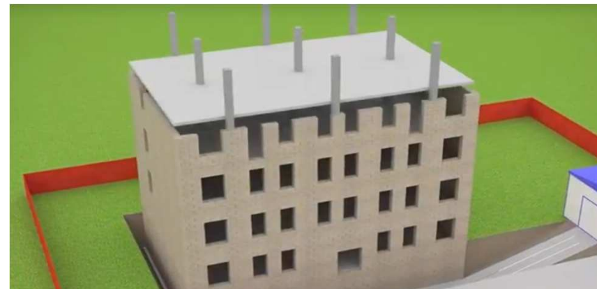
4. Сооружение внешних стен
